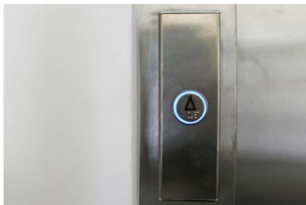
Botonera exterior, botón con sistema braille y retroiluminado.
