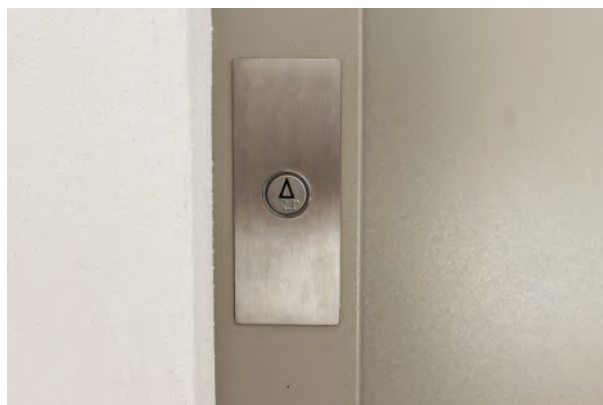
Clavier externe, bouton avec système braille et rétroéclairé.
