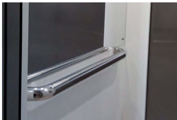
Détail de la main courante et du miroir.
