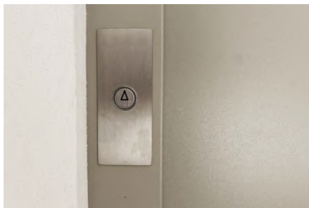
Botonera exterior, botón con sistema braiile y retroiluminado.
